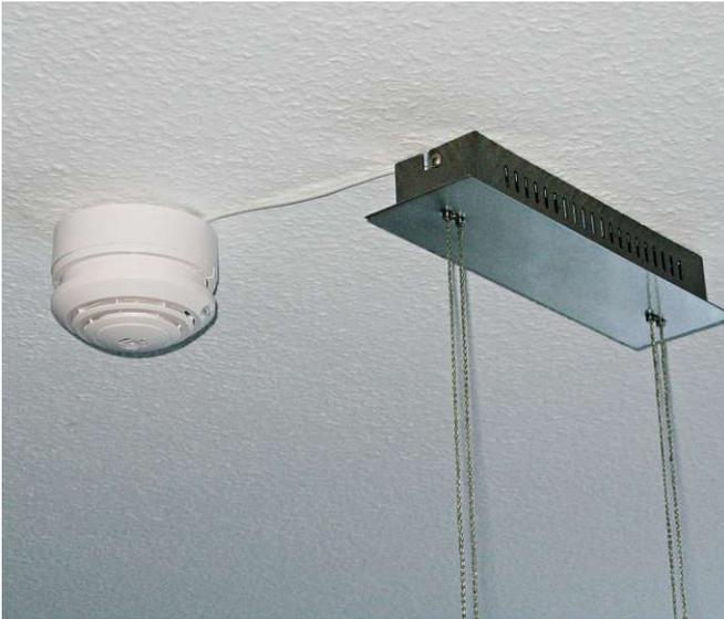
**Bild 39:** Die Einheit aus Bild 38 mit aufgesetztem Rauchmelder an einer Leuchte
